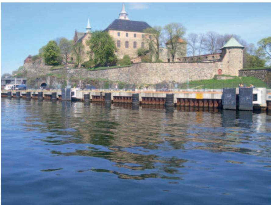
For store skip er det spesialkonstruerte fendere med fronter som er tilpasset skipenes skrog. I tillegg er kaia utstyrt med en rekke fendere av liggende gummi-hjul på hverandre i høyden. Fenderanordningene har blitt et dominerende og visuelt forstyrrende element i forhold til andre objekter på kaiene.
