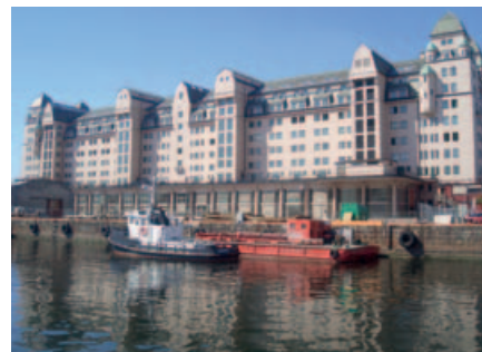
Havnelageret. Foto: Oslo Havn KF.
