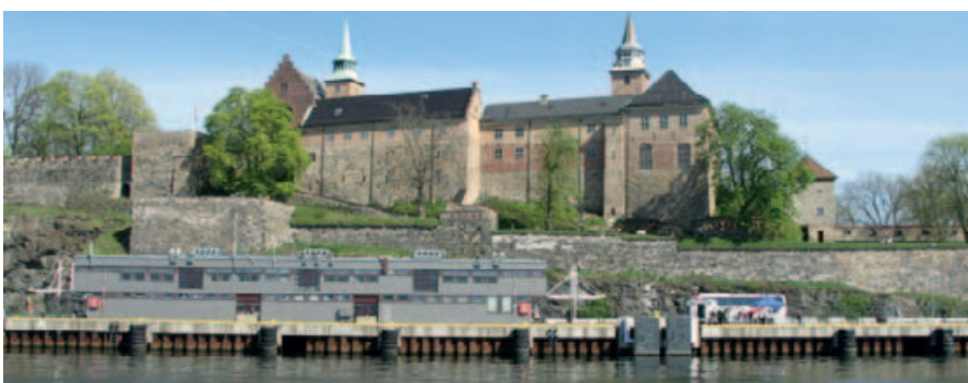
Søndre Akershuskai er et eksempel på en ny kombinasjonskai i Oslo havn. Det er i utgangspunktet en åpen stålørspalekai med betongdekke, men med en spuntvegg av stål i forkant.
