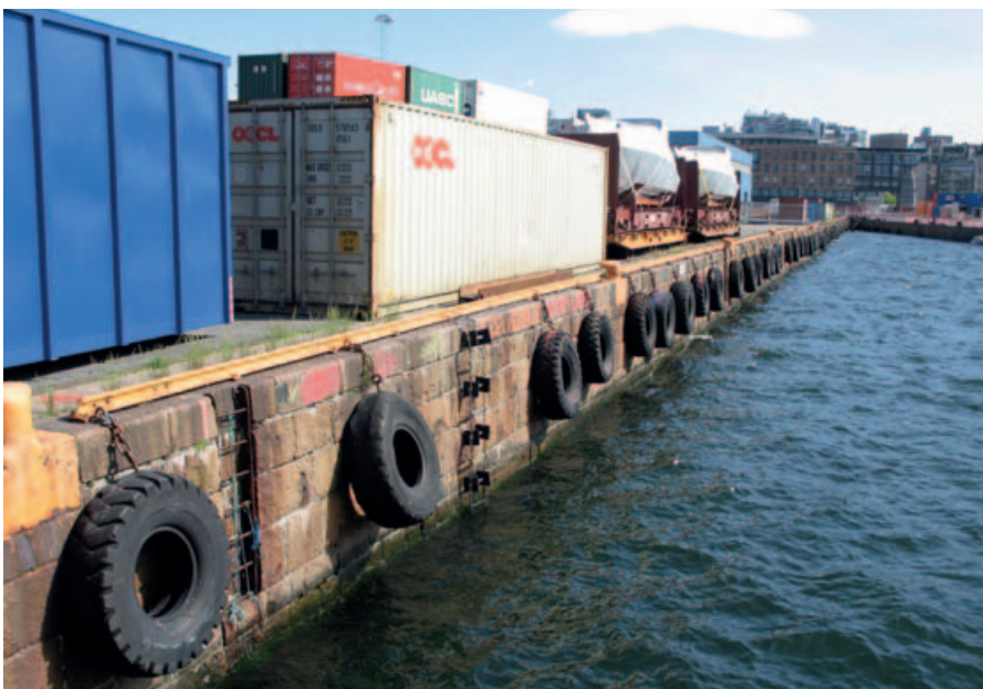
Blokk-mur på Filipstadkaia øst fra 1914–27. Granittmuren er bygget på en undervannsmur av 4–5 blokkerader (skift) av betong på bunnstøpning direkte på fjell eller grusfylling. Andre kaier som er bygget på tilsvarende måte med undervannsmur av betongblokker er Tjuvholmens ytre del, Utstikker II, Langkaia, Grønlikaiene, Nordre Sjørøykai og Søndre Bekkelagskai.
