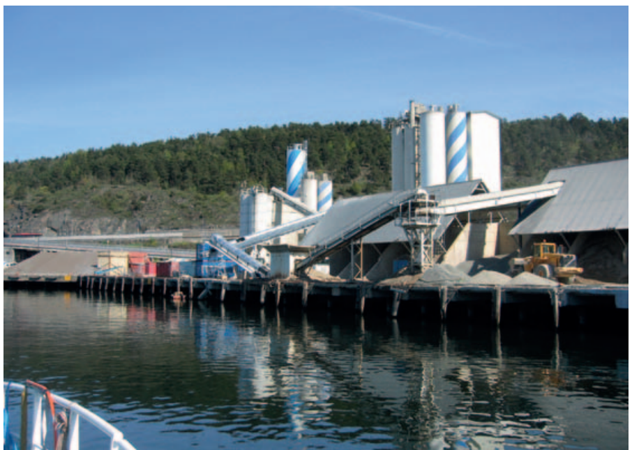
Betongfabrikk på Søndre Kongshavnskai. Foto: Fageraas, NIKU 2007.
