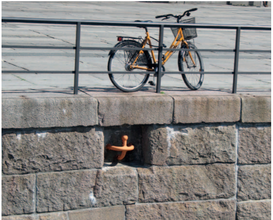
Fortøyningsanordning ved Rådhusbyggene. Foto: Fageraas, NIKU 2007.
