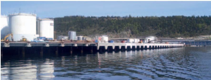
Kaia har nytt betongdekke som skjuler den gamle blokkmurskaia fra første del av 1900-tallet.
