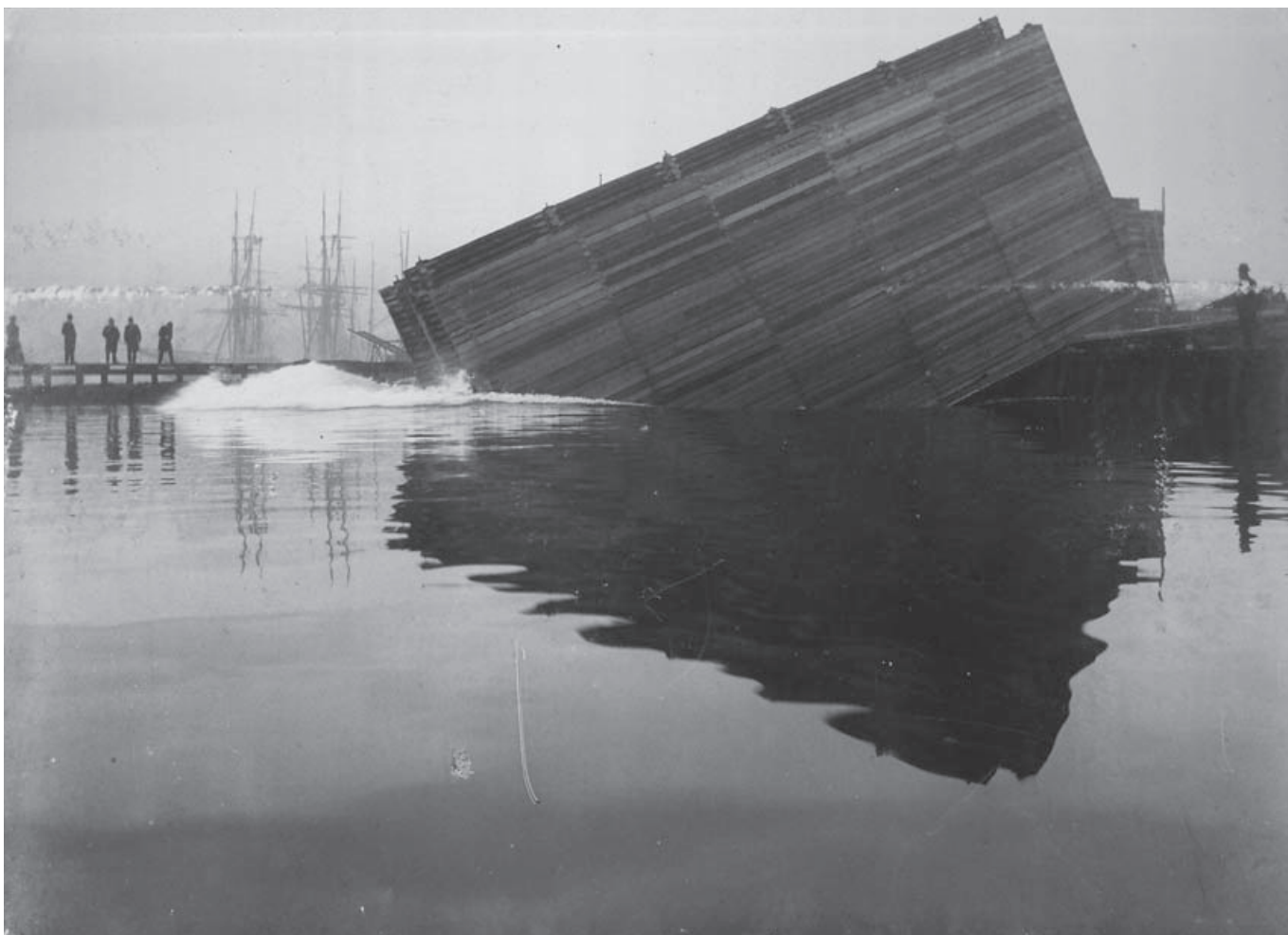
Laftekasse som sjøsettes på Vippetangen, 1899. Den eksisterer fortsatt som fundament for Vippetangkaia i dag.
