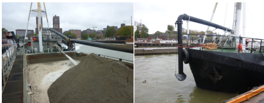
Figur 8 Utlegging av sand med "Rainbowing" fra Arena i Pipervika. Til venstre vises det hvordan det spyles vann inn i lasterommet med dekkmasser for å gjøre sanden pumpbar. Til høyre sees arrangementet med diffusor for "Rainbowing" av massene.
