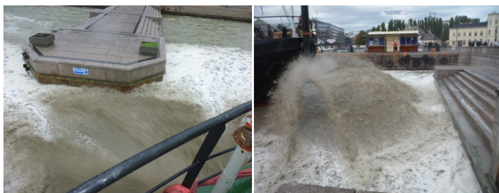
Figur 9 Utlegging av sand med "Rainbowing" fra Arena i Pipervika. Bildene viser hvordan metoden gjør det mulig å legge dekkmasser godt inntil bryggekannten.
