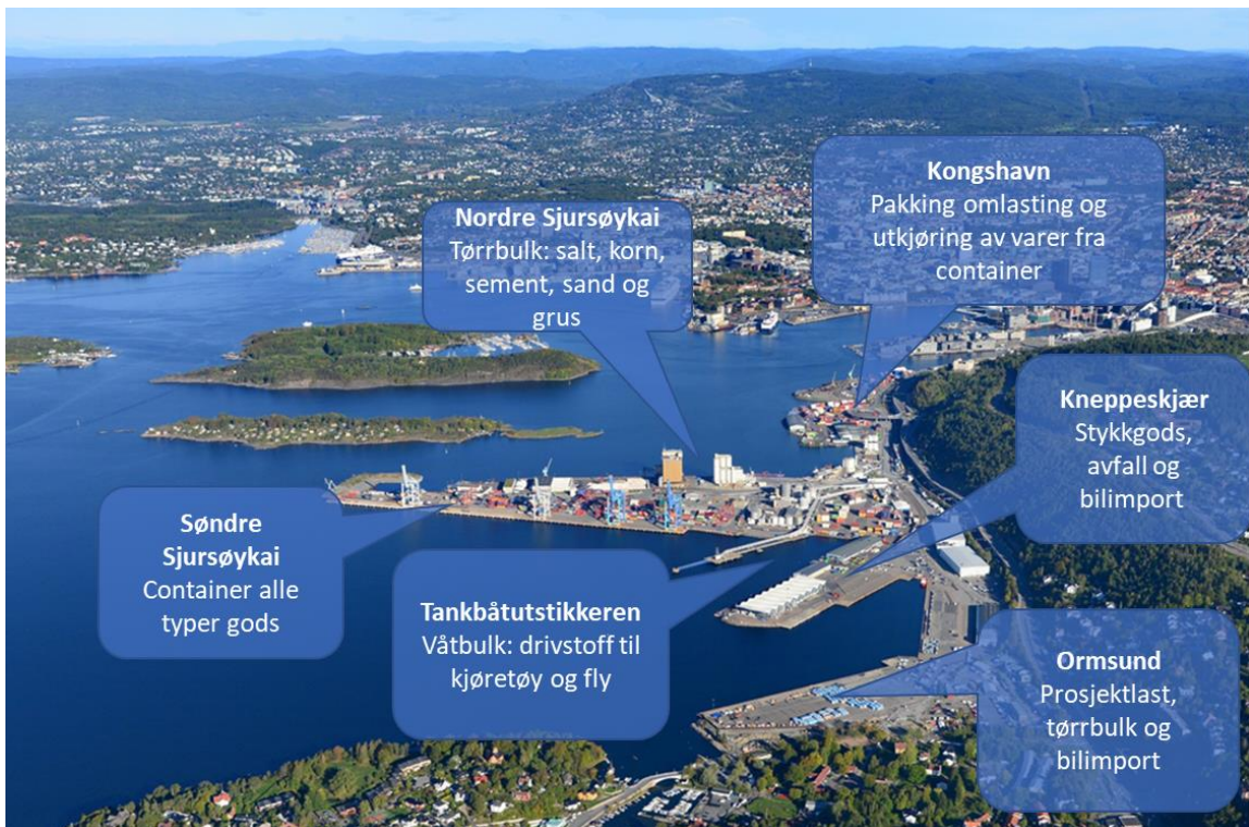
Figur 4 Bildet viser lokasjonen til de ulike terminalene i Oslo havn og hvilke typer gods som håndteres på Sydhavna.
