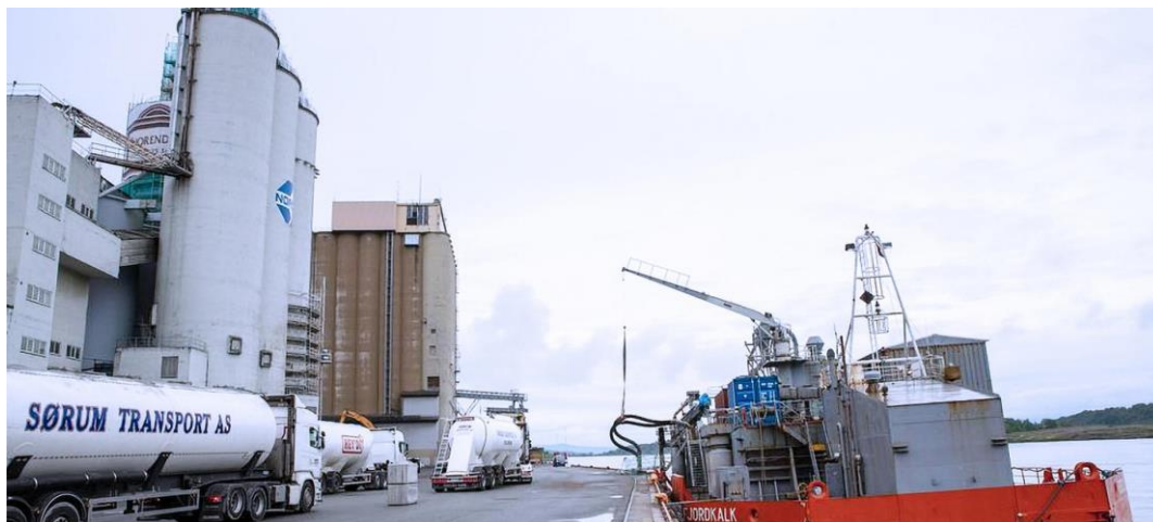
Figur 19 Bildet viser sementlekteren Fjordkalk som pumper sement opp i siler ved hjelp av skipets generatorer.
