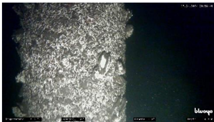
Figur 10: Pæle med kalkrørsormer og østers. Under Operaen i Bjørvika.
