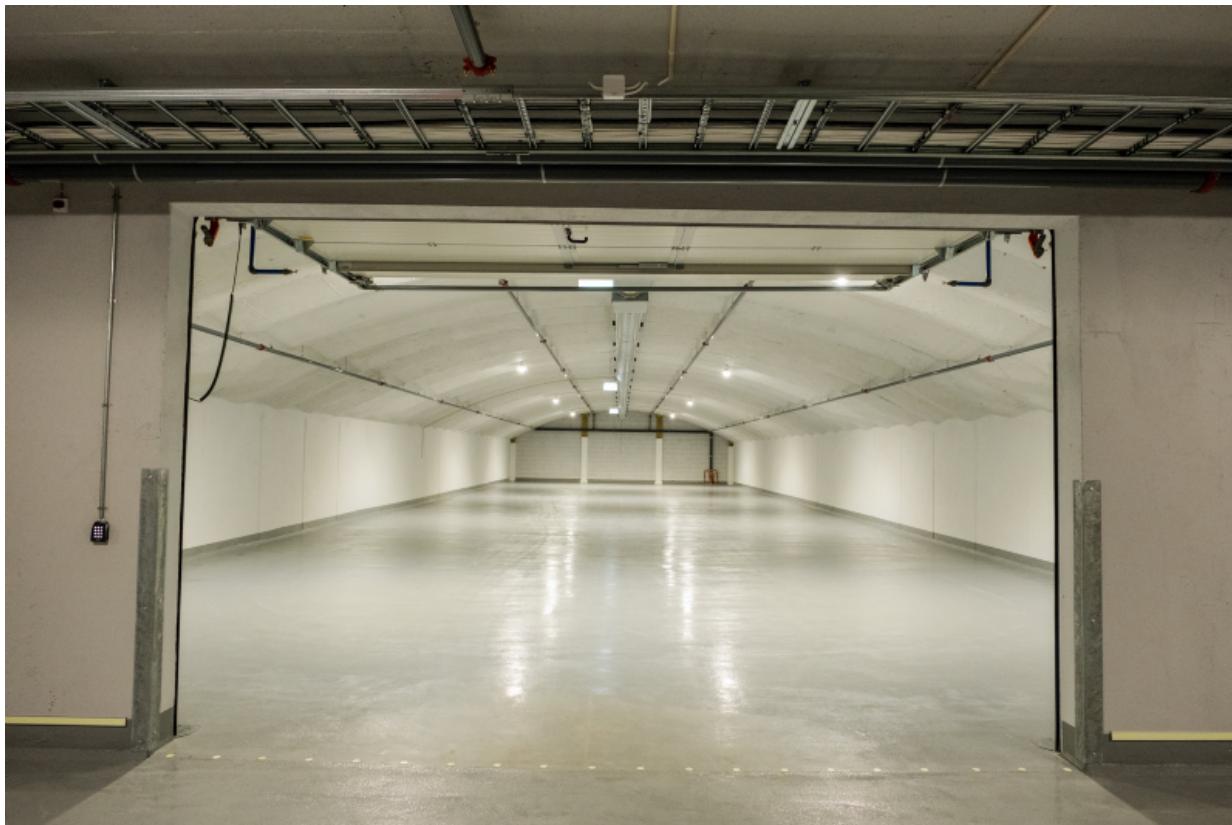
Fig. 3 Lagerhall i 2. etg. etter rehabilitering
