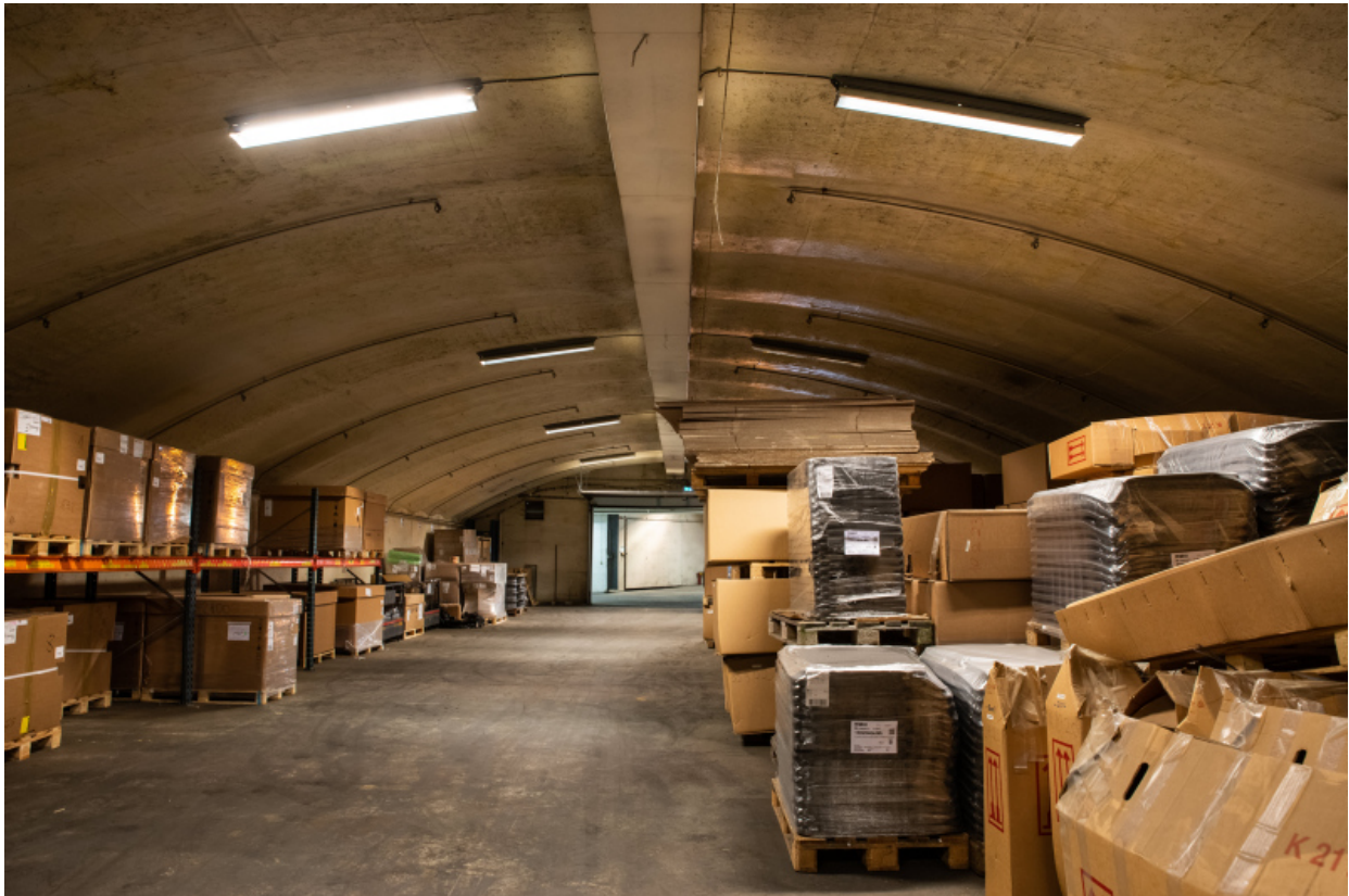
Fig. 2 Lagerhall i 2. etg før rehabilitering
