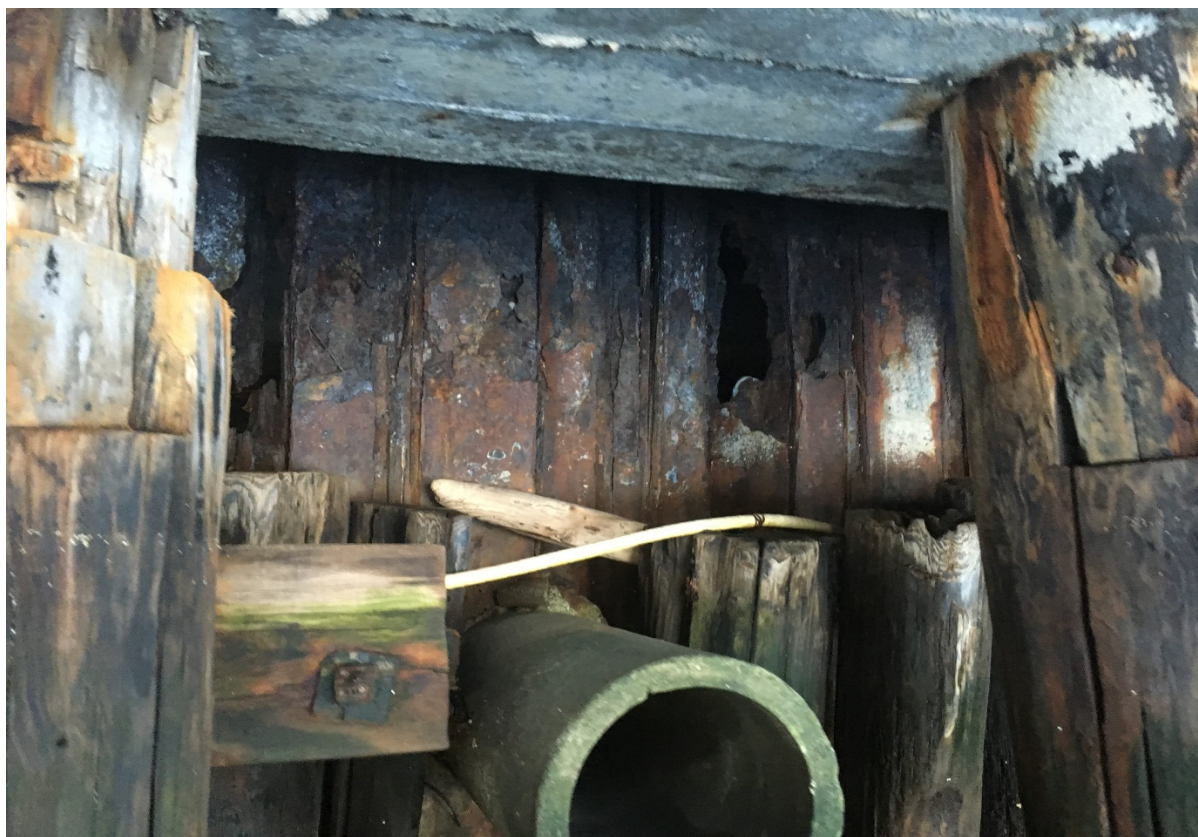
bilde 1: Bærende konstruksjon under kai på Akershusutstikker før oppgradering; trepeler og spuntvegg
