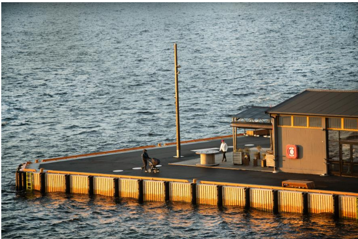
Ferdig rehabilitert Akershusutstikkeren ble åpnet 8. januar.
