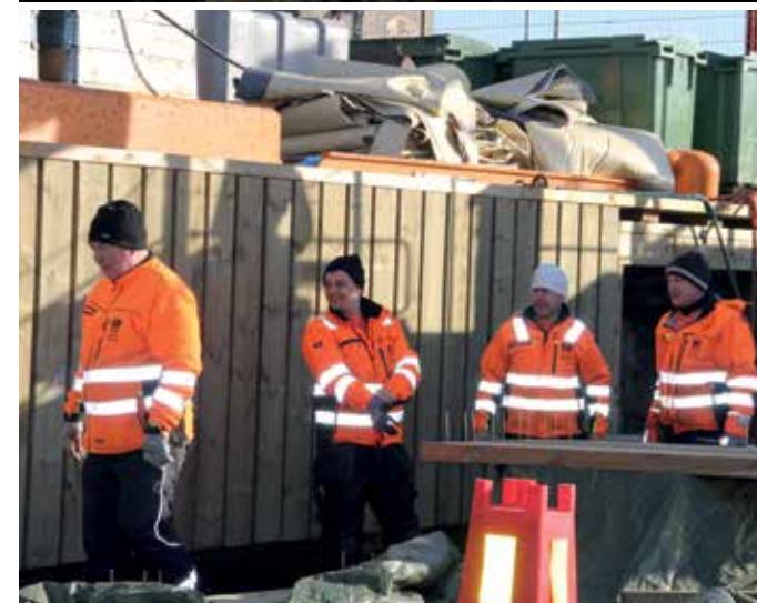
Hele arbeidslaget. Bjørn Arild Hansen og Leif Kvam (fra høyre) sammen med Egon Jensen og Milan Miletic på tømmermannspram 31.
