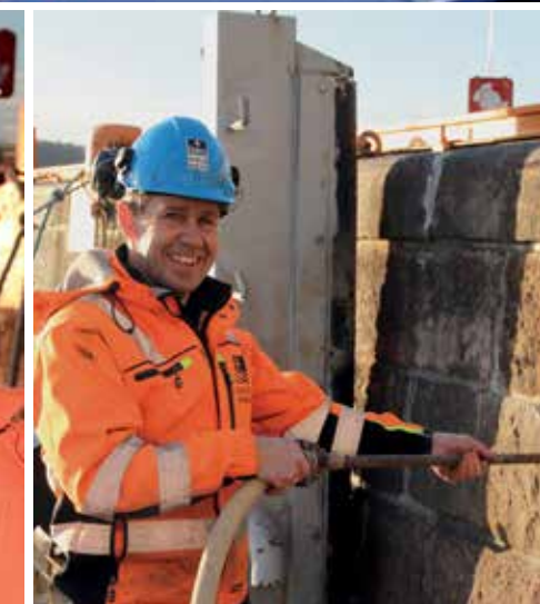
Bjørn Arild borrar ut den gamle mørtelen på den verneverdige blokkmurskaia i granitt på Vippetangen.
